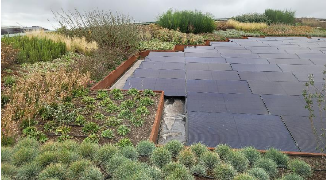
Dachbegrünung mit PV-Anlage (© HLNUG, Kuckuk)
